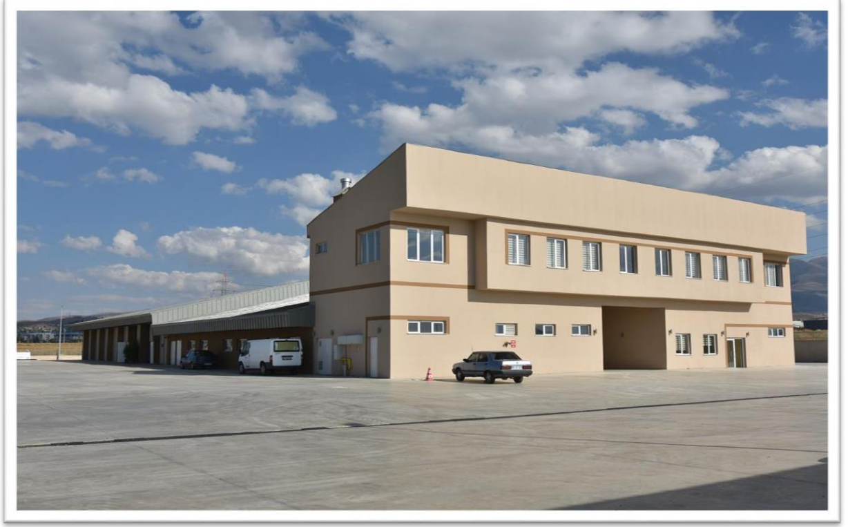
Resim 10: Kapalı Garaj ve Güvenlik Binasından Görünüm
