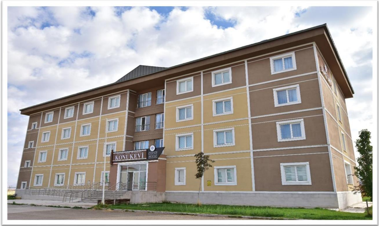
Resim 12: Konukevi Binasından Dış ve İç Görünüm
