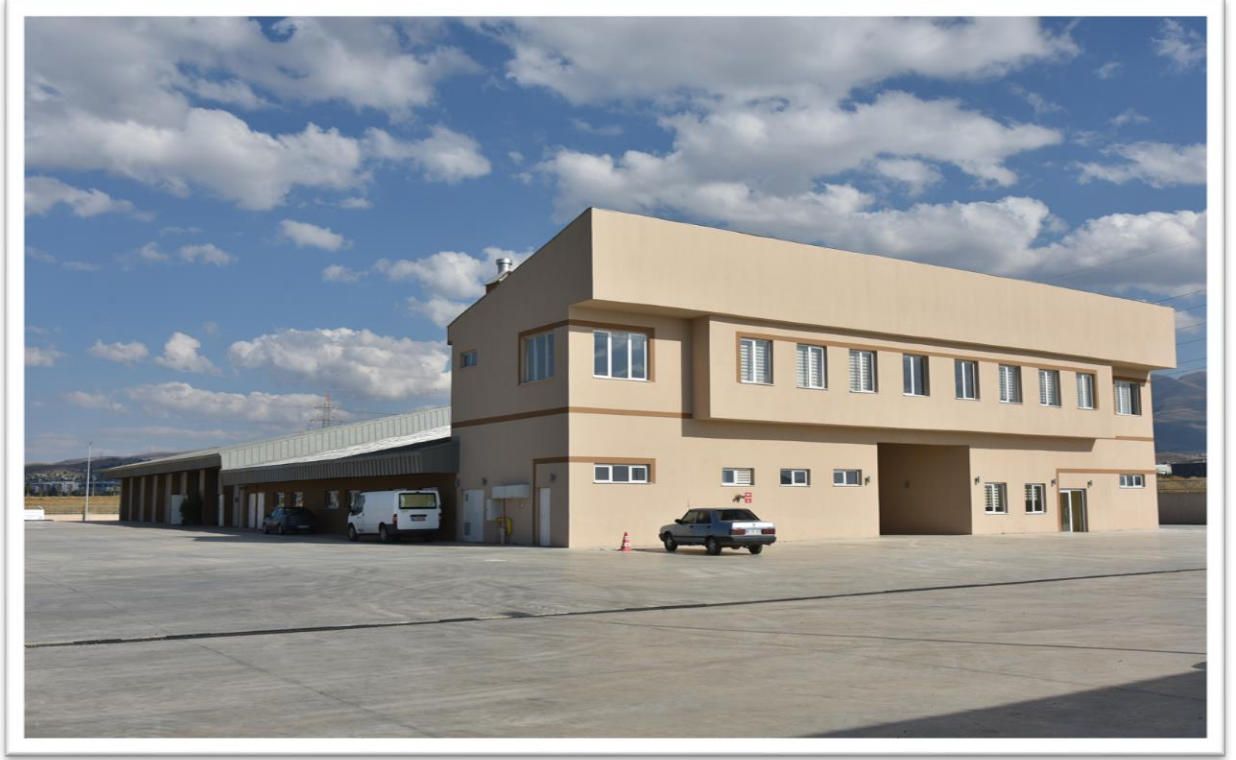
Resim 10 : Kapalı Garaj ve Güvenlik Binasından Görünüm
