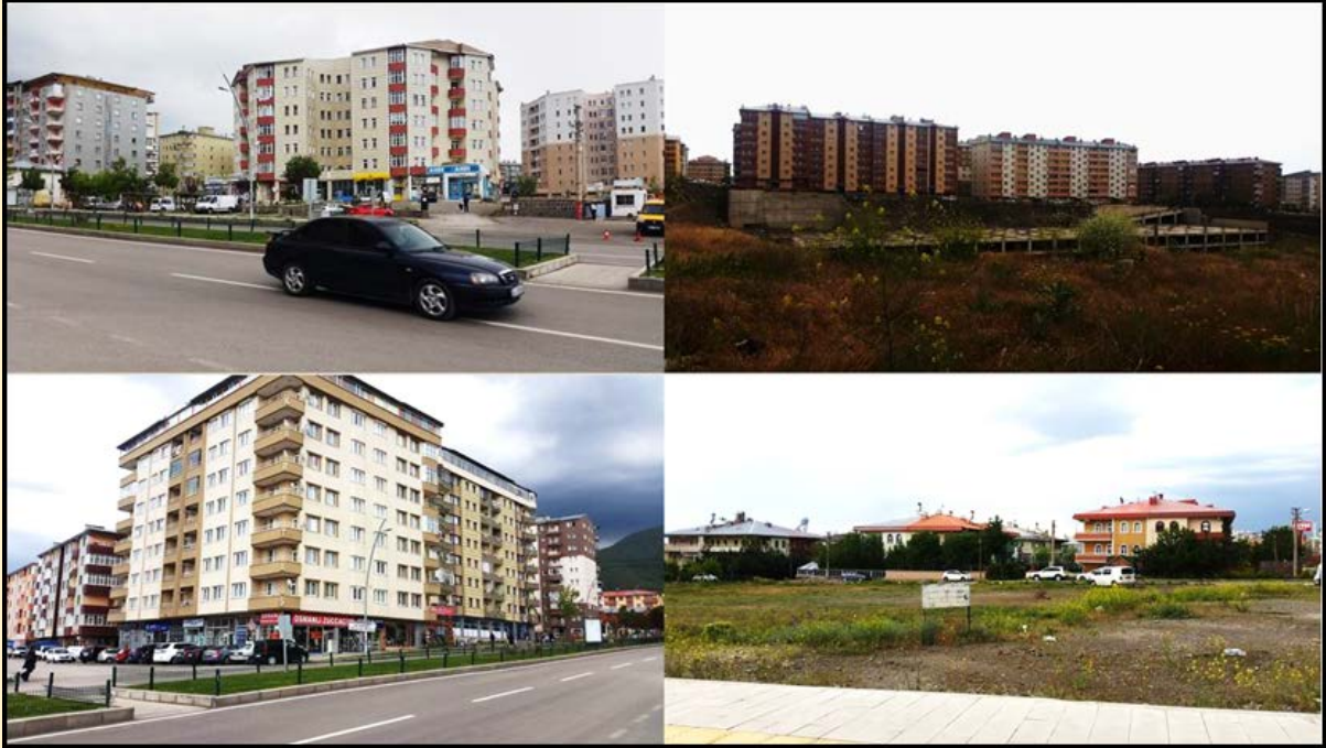
Fotoğraf 5. Şehrin güneybatı gelişim alanında bulunan Yıldızkent'te çok katlı apartmanların yanı sıra iki katlı bahçeli evler de bulunabilmektedir.
