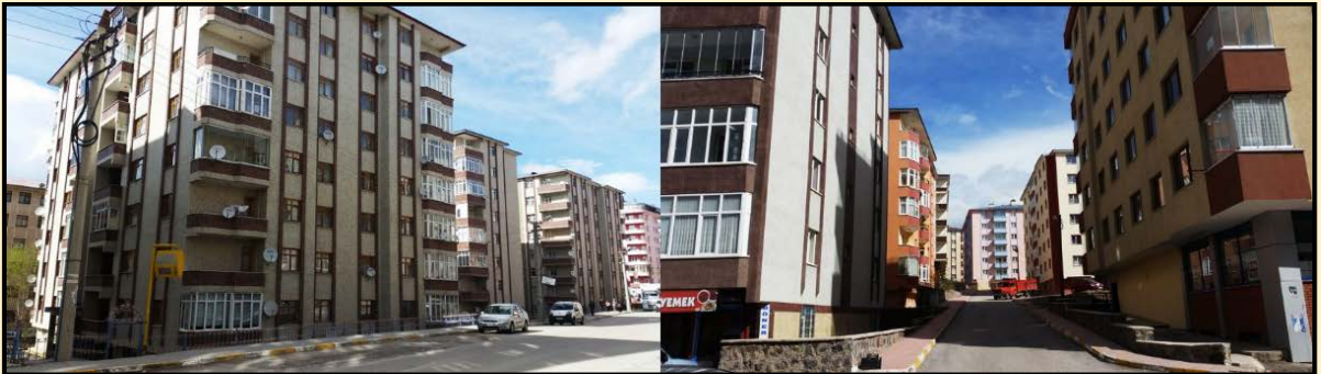
Fotoğraf 6. Kayakyolu semti Erzurum şehrinin güneye doğru gelişim alanında bulunup, çok katlı apartmanların bulunduğu sık dokulu bir forma sahiptir.
