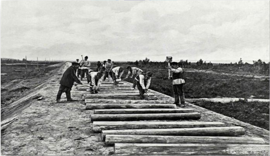
EK 5: Demiryolu inşaatında çalışan işçiler (Bk. www.rzd-expo.ru ).
