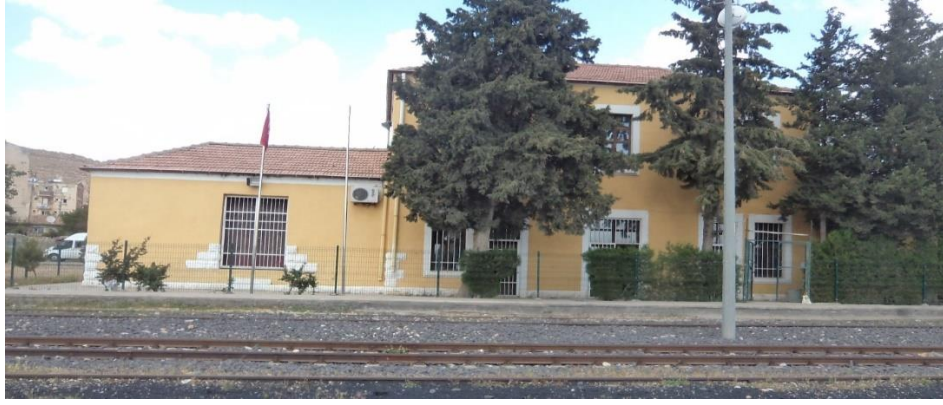
Ek.5. Eski Nusaybin Tren İstasyonu 13
