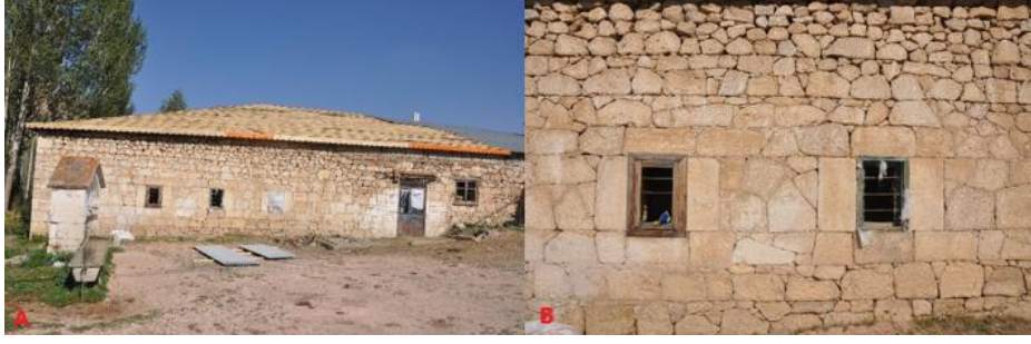
Şekil 8. A. Han Yapısının Genel Görünümü B. Yapının Duvar Örgüsü
