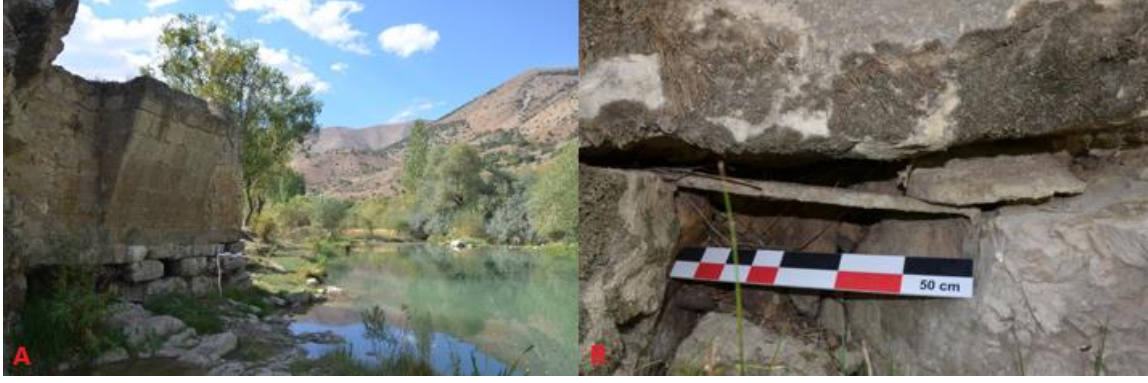
Şekil 9. A. Köprü Ayağının Genel Görünümü B. Temel Duvarındaki Zıvana Örneği
