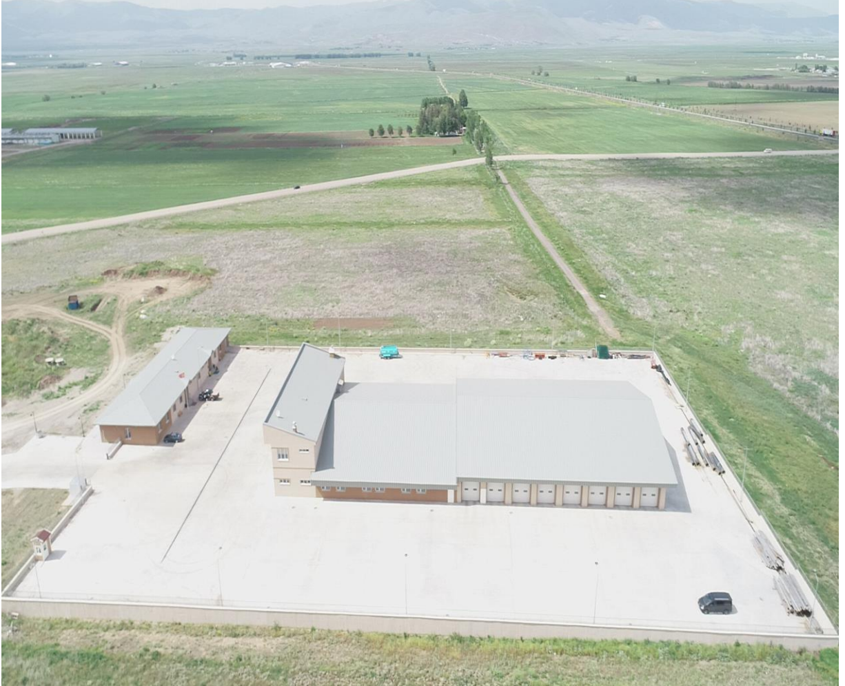
Resim 10: Merkezi Kapalı Garaj
