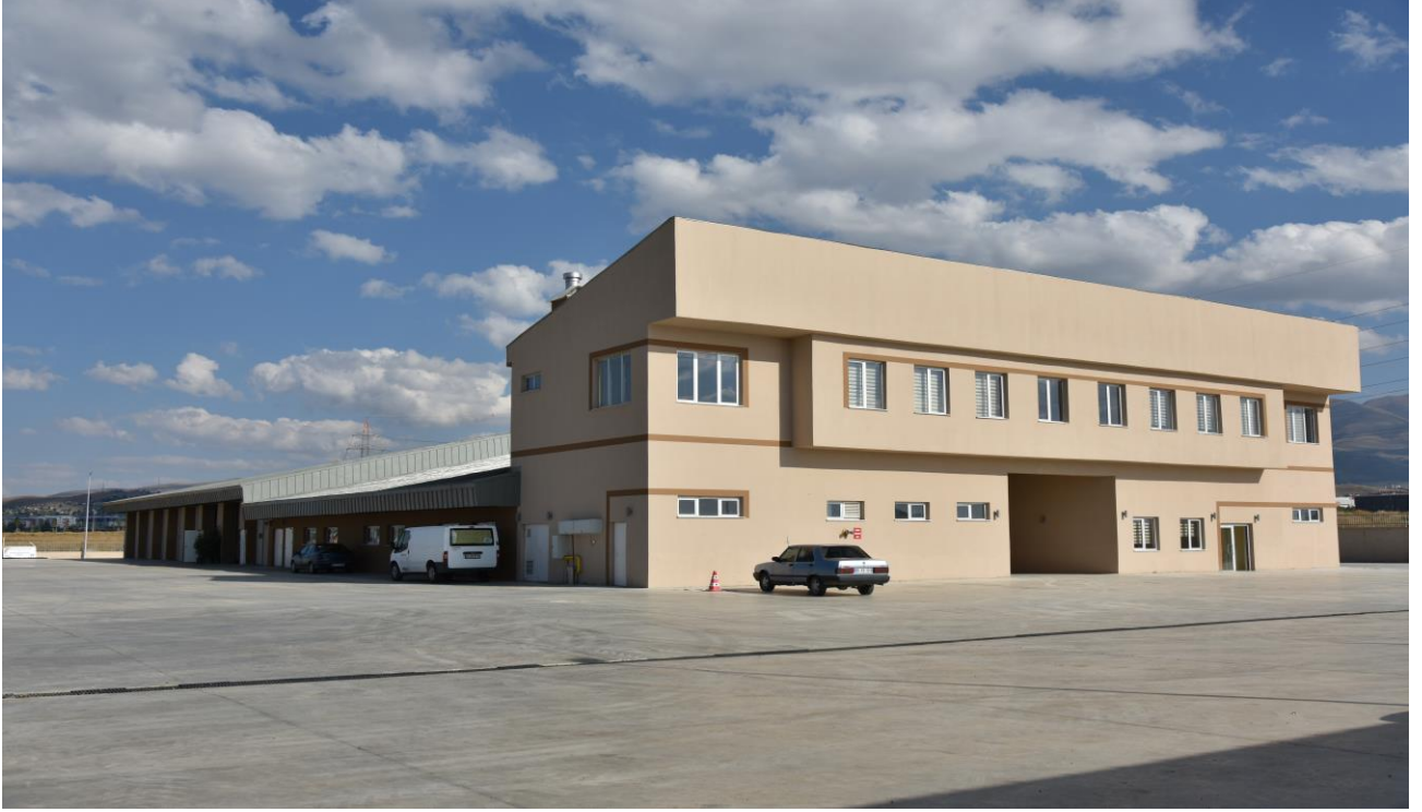
Resim 10 : Kapalı Garaj ve Güvenlik Binasından Görünüm
