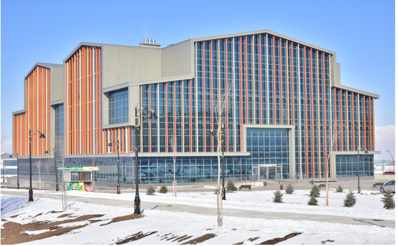
Resim 5 : Merkez Kütüphane Binasından Görünüm
